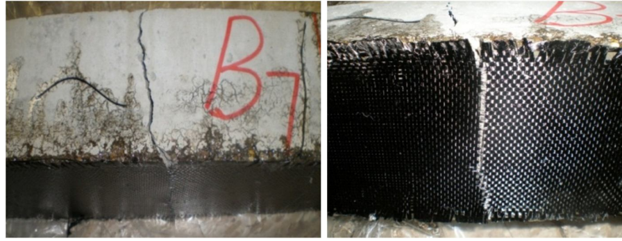
شكل (9) تشقق الخرسانة في الكمرة 7- نتيجة حمل الإحناء شكل (10) تمزق ألياف البوليمر بالكمرة (7)
