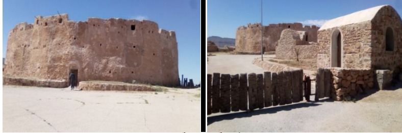
الصورة رقم (7) و (8) توضح قصر الحاج وأبوابة الرئيسية المصدر: تصوير الباحث
